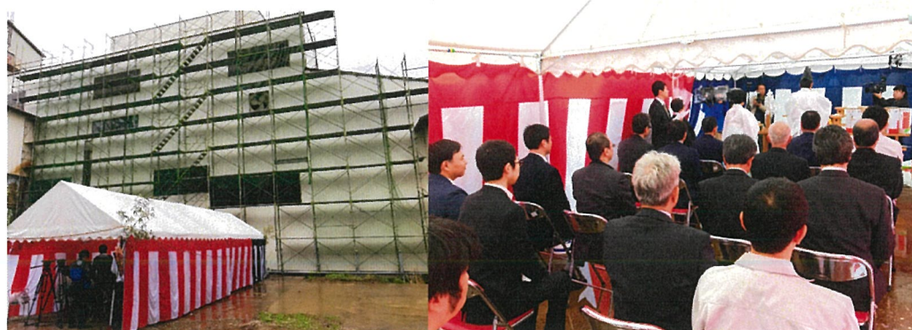
写真① 建設場所
